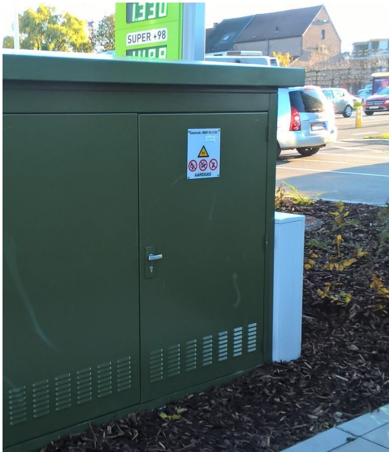
Afbeelding tele-opnamekast van Fluvius (rechts van gascabine)
